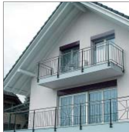
6.5a EFH mit geschützten Fassadenteilen.
